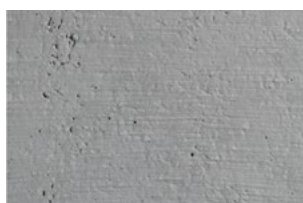
Tehnika grubog betona
