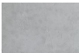
Tehnika glatkog betona
