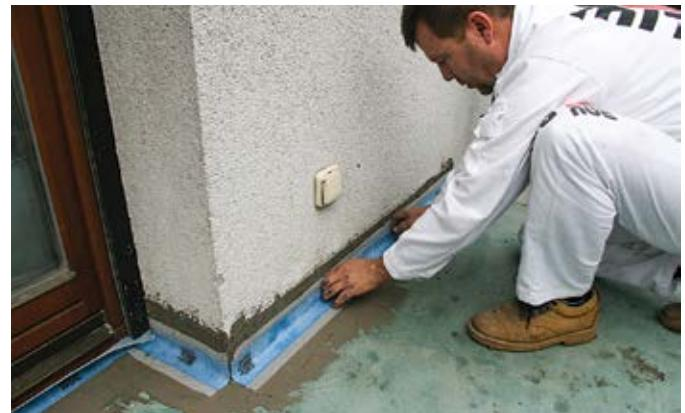
Za brtviljenje spoja pod/zid, odnosno dilatacijskih fuga na podlogu koristiti trake za brtviljenje Baumacol. Trake postavite ravnomjerno pritiskanjem u prvi svježi sloj hidroizolacijske mase Baumacol Protect 2K Elastic.
