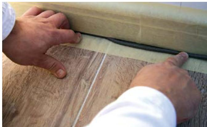
Dilatacijska fuga u spoju pod/zid, estrih/estrih ili odvodni profil/pločica: u fugu širine min. 3 mm potrebno je umetnuti uže za brtviljenje koje je za oko 25% šire od širine fuge, tako da se cijelo smjesti u fugu.
