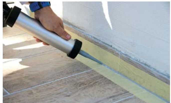
Nakon umetanja užeta za brtviljenje potrebno je ravnomjerno ispuniti fugu Baumacol silikonom. Prije brtviljenja, potrebno je zaštititi područje oko fuge ljepljivom trakom.
