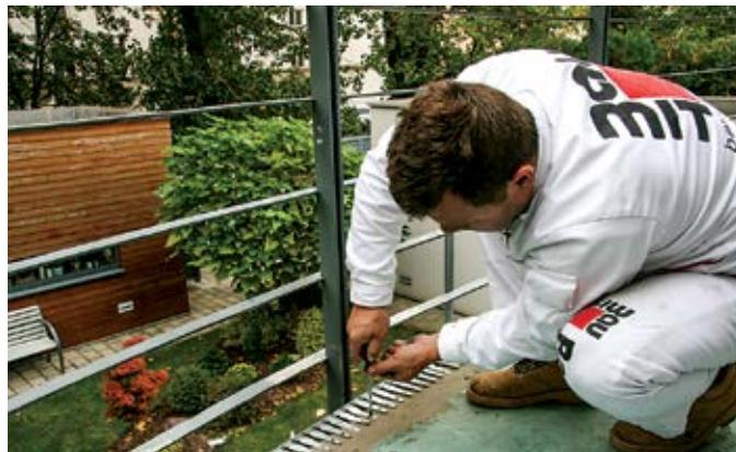
Nakon postavljanja Baumit Balkonskog profila u sloj hidroizolacijske mase, po potrebi je moguće mehanički učvrstiti profil na nosivu podlogu uz pomoć vijka. U dijelu spajanja profila potrebno je održati dilataciju od najmanje 4 mm koja se preklapa spojnim dijelom.
