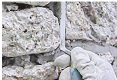
Izdubiti i očistiti sljubnice do dubine od 2 cm; Oprati površinu visokotlačnim čistačem. Pustiti da se osuši.
