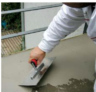
Slika 1. Ugradnja hidroizolacije
