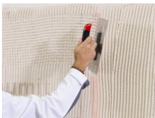
Slika 2. Nanošenje žbuke i utiskivanje mrežice
