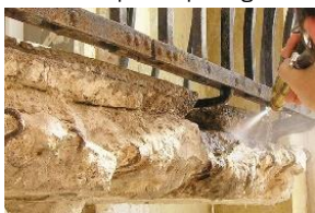
Slika 2. Priprema podloge
