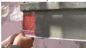
Slika 5. Obrada bočnih strana balkona s Baumit BetoFill/Finish i ugradnja okapnog profila
