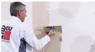
Slika 4. Nanošenje mase za zaglađivanje
