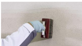
Slika 3. Nanošenje predpremaza
