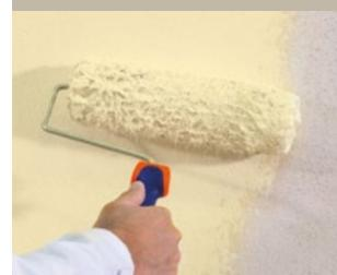
Neupojne i zatvorene površine trebaju vezivo koje će služiti za prionjivost budućih slojeva.
