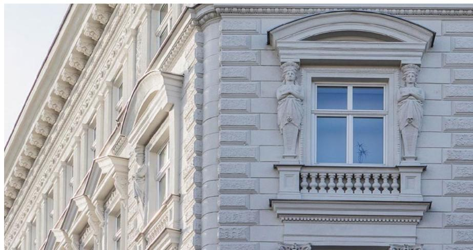
fasadnih žbuka koje su predviđene u tu svrhu. Da bi se postigla dugotrajna, lijepa površina žbuke, prvo se mora osušiti zid te je potrebno osigurati da nova vлага ne može ući u zidove.
