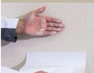
Pjeskovite površine smanjuju stabilnost novog premaza i mogu uzrokovati guljenje novo nanesenog sloja boje.
