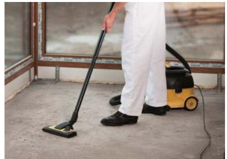
Prije postavljanja estriha vezanog uz podlogu vrlo je važno pažljivo uklanjanje nečistoća s podloge
