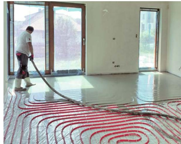
Veća površina izvora topline omogućava korištenje nižih temperatura za grijanje, što rezultira uštedom energije do 12% (prema podatcima BVF-a, tj. njemačkog Saveznog udruženja za površinsko grijanje i površinsko hlađenje, njem. Bundesverband Flächenheizungen und Flächenkühlungen e.V.)
