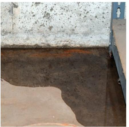
Bez posebnog postupka sušenja estriha postoji opasnost kod estriha s vlažnim izolacijskim slojem kod masivnih podloga da voda ostane mjesecima u strukturi konstrukcije, što može rezultirati dugotrajnim posljedičnim oštećenjima drugih građevinskih elemenata u kontaktu sa estrihom i nastankom pljesni.
