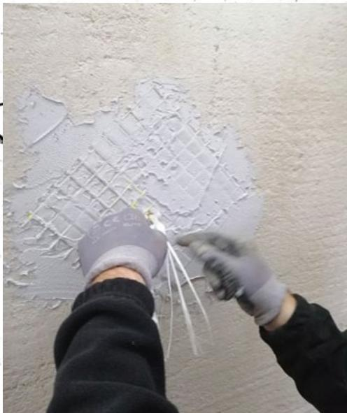
**Opis slike:** Ojačanje potresom oštećenog zida s mortom za armiranje Baumit NHL SicuroProtect i Baumit SicuroTex mrežicom. Mrežica za armiranje je pričvršćena u tlo pomoću Baumit SicuroConektor-a i Baumit SicuroFixator-a.
