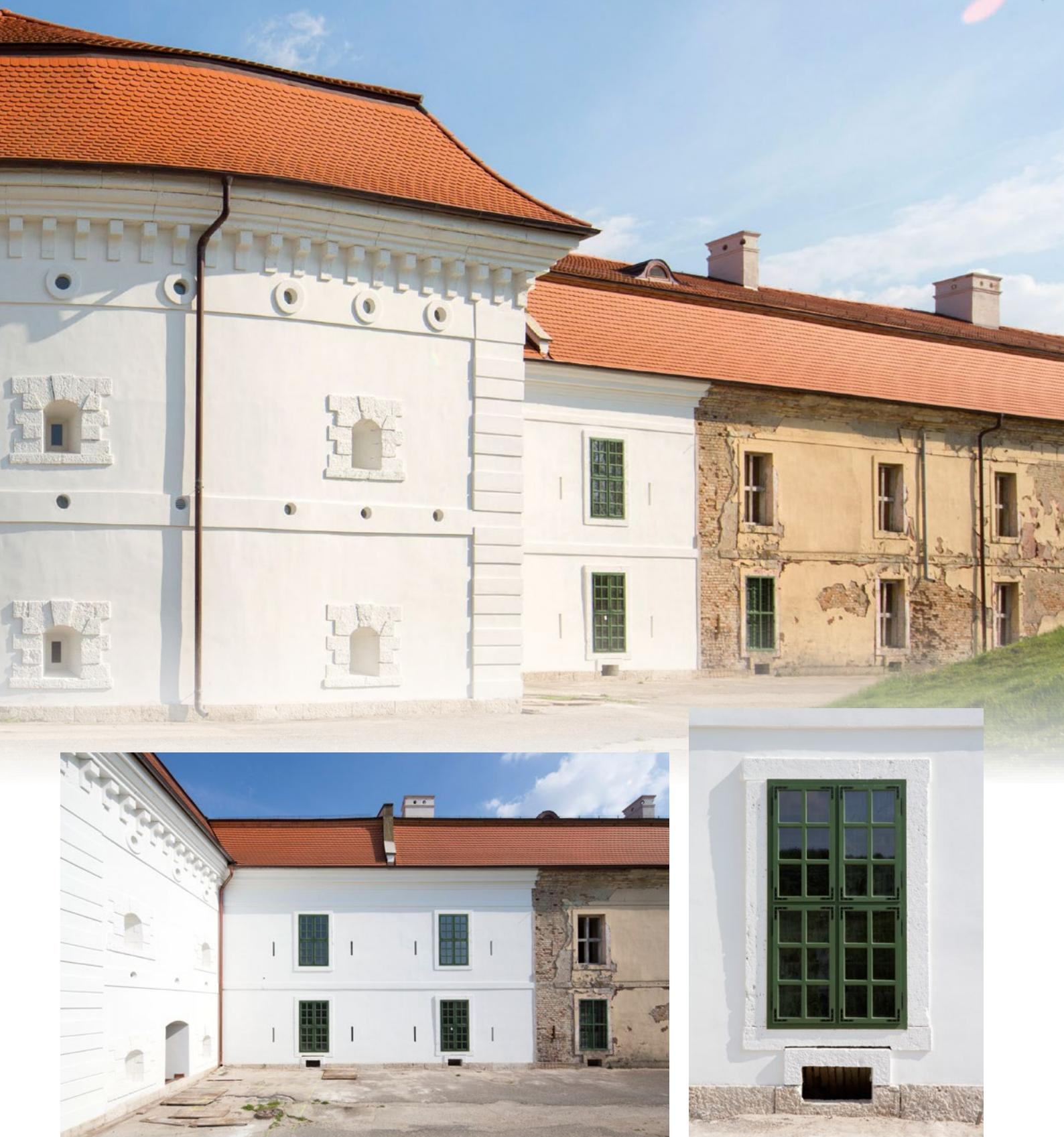
injektiranje zida i obrada žbuke fiksatorom, po potrebi, a cijela obnova odradena je sanacijskim sustavom Baumit Sanova. U prvom koraku nanesen je temeljni predpremaz Baumit SanovaPrimer sa 100% prekrivanjem. Za prvi sloj žbuke korištena je žbuka Baumit Sanova MonoTrass WTA. Posljednji sloj sastoji se od fine žbuke Baumit SanovaFine. NHL Manu i Fine korišteni su za štukature i finije površine. Na temelju istraživanja na tvrđavi Komárno,
