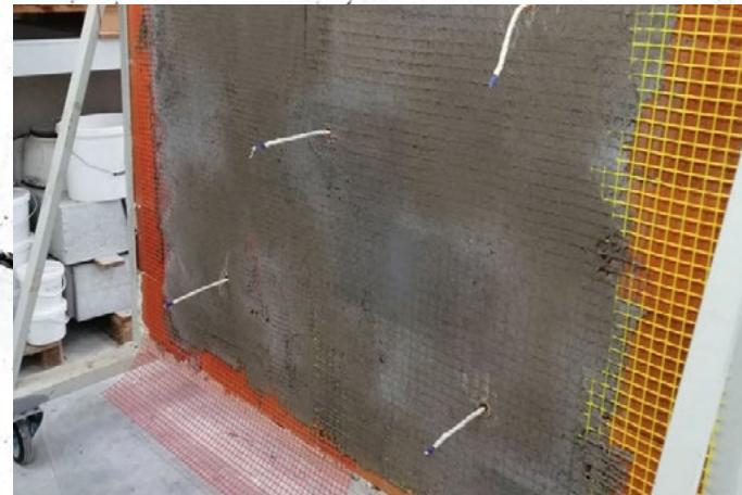
**Opis slike:** Lijepljenje vlakana Baumit SicuroConektor-a pomoću Baumit SicuroTex u armaturnom sloju.
