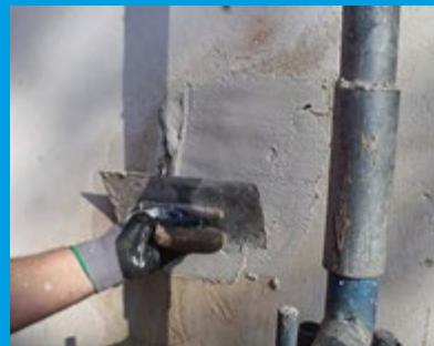
**1.** *Uništena stara žbuka mora se temeljito ukloniti najmanje 1 metar iznad vidljive granice vlage, zatim se ziđe mora temeljito očistiti. Nakon toga obvezno s površine očistiti prašinu metlom ili usisavačem. Nikako ne koristiti vodu za čišćenje površine jer će to opet otopiti soli koje će naposljetku izbiti na površinu.*
