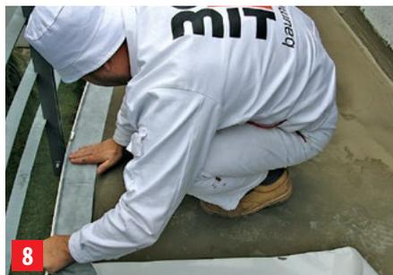
8 Doticaj prvog sloja i odvodnog profila prekriti butilnom samoljepljivom trakom Baumit samoljepljiva brtvena traka koja će učvrstiti i zabrtviti balkonski profil.
