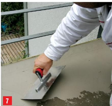
7 Drugi sloj mora duž cijele plohe prekrivati prvi sloj, uključujući i trake za brtvljenje i balkonske trake.
