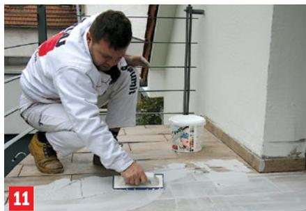
11 Fugirnu masu Baumacol PremiumFuge dijagonalno pritisnemo u fuge pomoću gumene mase. Fugiranu plohu oprati nakon cca 5 do 15 minuta čistom vodom i mekom spužvom.
