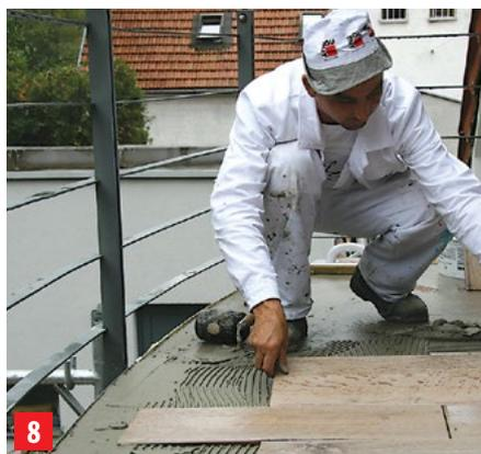
8 Nakon 24 sata naljepiti pločicu kombiniranom metodom lijepljenja „Buttering-Floating“, tj. lijeplilo nanijeti na podlogu i poledinu pločice.
