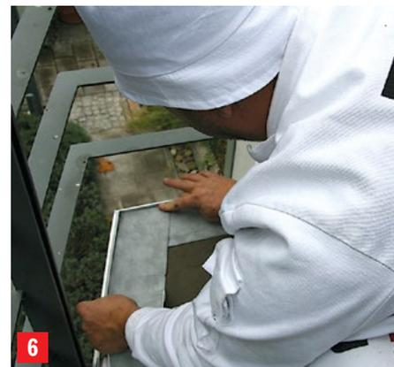
6 Doticaj prvog sloja i odvodnog profila prekriti butilnom samoljepljivom trakom Baumit balkonska traka koja će učvrstiti i zabrtviti balkonski profil.
