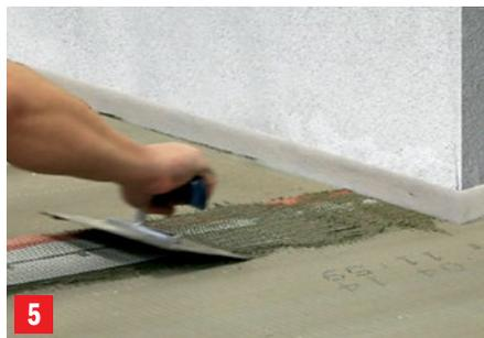
5 Spojeve pojedinih dasaka učvrstiti mrežicom od staklenih vlakana Baumit StarTex u širini od minimalno 20 cm umetnutom u ljepilo Baumacol FlexTop/FlexTop Speed.
