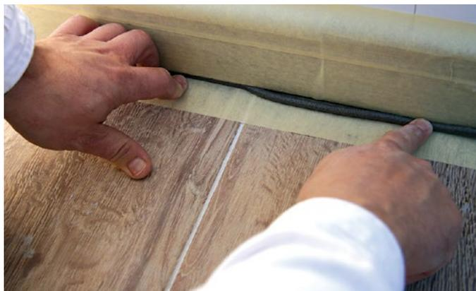
Dilatacijska fuga u spoju pod/zid, estrih/estrih ili odvodni profil i pločica: u fugu širine min. 3 mm potrebno je umetnuti užeta za brtvljenje koje je za cca 25% šire od širine fuge, tako da se cijelo smjesti u fugu.
