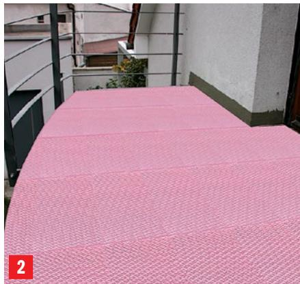
2 Na podlogu očišćenu od prašine naljepiti termoizolacijske ploče XPS-P/EPS 150S, 200S.
