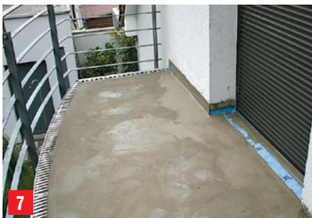
7 Prvi sloj hidroizolacijske mase Baumacol Protect 2 K Elastic izvesti tako da debljina sloja bude najviše 1 mm.
