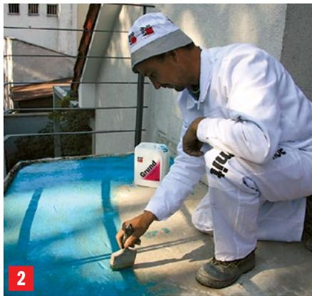
2 Podlogu očišćenu od prašine obrađujemo predpremazom Baumit Grund/SuperGrund.
