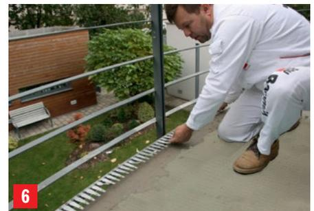
6 Na podložni plivajući sloj nanijeti predpremaz Baumit Grund. Baumit Balkonski profil postaviti duž hidroizolacijske mase Baumacol Protect 2 K Elastic. Za brtvljenje spojeva pod/zid, odnosno dilatacijskih fuga na podlozi je potrebno upotrijebiti hidroizolacijsku traku Baumacol Traka za brtvljenje.
