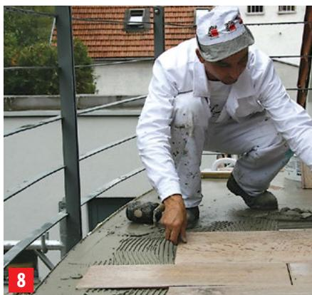
8 Nakon 24 sata nalijepiti pločicu kombiniranom metodom lijepljenja „Buttering-Floating“, tj. lijeplilo nanijeti na podlogu i poledinu pločice.
