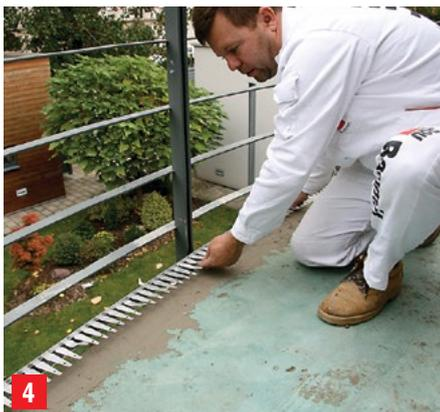
4 Na podložni plivajući sloj nanijeti predpremaz Baumit Grund. Baumit Balkonski profil postaviti duž balkonske konstrukcije tijekom realizacije 1. sloja hidroizolacijske mase Baumacol Protect 2 K Elastic. Za brtvljenje spojeva pod/zid, odnosno dilatacijskih fuga na podlozi je potrebno upotrijebiti hidroizolacijsku traku Baumacol Traka za brtvljenje.
