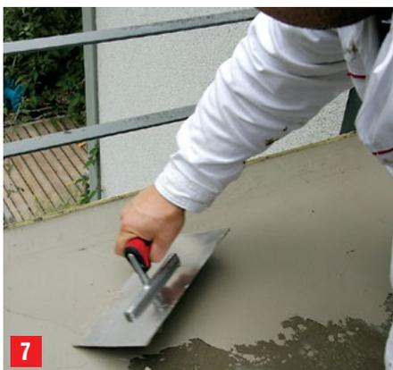
7 Drugi sloj hidroizolacijske mase nanositi nakon cca 2 sata duž cijele plohe tako da ukupna debljina oba sloja bude minimalno 2 mm. **Drugi sloj mora duž cijele plohe prekrivati prvi sloj, uključujući i trake za brtvljenje i balkonske trake.**
