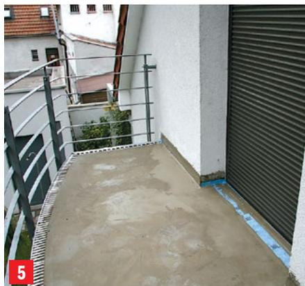
5 Prvi sloj hidroizolacijske mase Baumacol Protect 2 K Elastic izvesti tako da debljina sloja bude najviše 1 mm.
