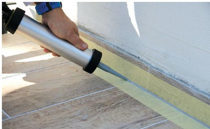
Nakon umetanja užeta za brtvljenje potrebno je ravnomjerno ispuniti fugu Baumacol silikonom. Prije brtvljenja područje oko fuge potrebno je zaštititi ljepljivom trakom.
