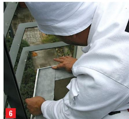
6 Doticaj prvog sloja i odvodnog profila prekriti butilnom samoljepljivom trakom Baumit samo-ljepljivom trakom za brtvljenje koja će učvrstiti i zabrtviti balkonski profil.
