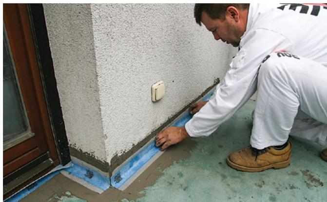
Za brtvljenje spoja pod/zid, odnosno dilatacijskih fuga na podlogu koristite trake za brtvljenje Baumacol. Trake postavite ravnomjerno pritiskanjem u prvi svježi sloj hidroizolacijske mase Baumacol Protect 2 K Elastic.
