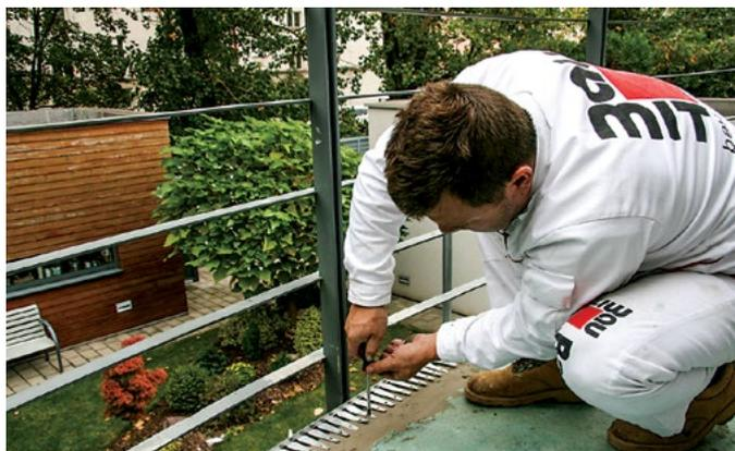
Nakon postavljanja Baunit Balkonskog profila u sloj hidroizolacijske mase, po potrebi je moguće mehanički učvrstiti profil na nosivu podlogu uz pomoć vijka. U točki spajanja profila potrebno je održati dilataciju od najmanje 4 mm koja se prekriva spojnim dijelom.
