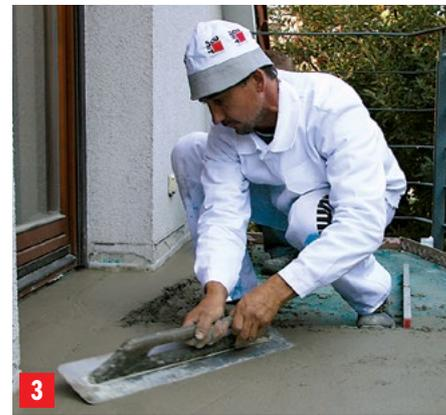
3 Plivajući sloj izrađujemo pomoću plivajućeg betona Baumit FlexBeton.
