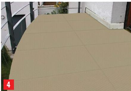
4 Izolacijske ploče Uni nanijeti kombiniranom metodom „Buttering-Floating“, tj. ljepilo nanijeti na podlogu i na izolacijsku ploču. U slučaju lijepljenja ploča ljepilom Baumacol FlexTop, ploče su prohodne već nakon 3 sata.
