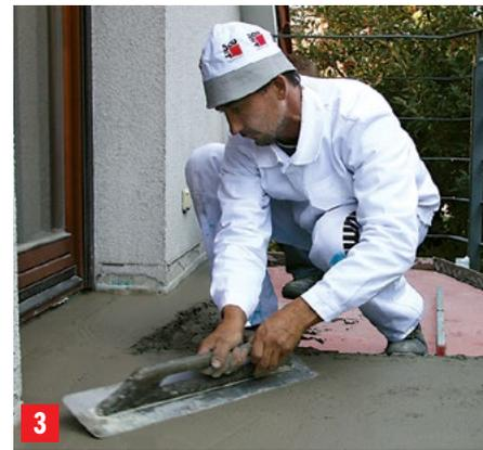
3 Plivajući sloj izraditi pomoću plivajućeg betona Baumit FlexBeton u debljini od minimalno 30 mm.
