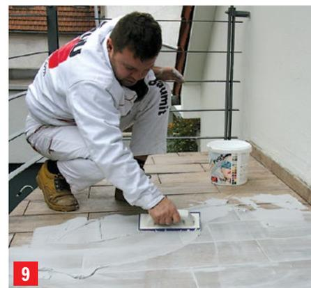
9 Fugirnu masu Baumacol PremiumFuge dijagonalno pritisnemo u fuge pomoću gumene mase. Fugiranu plohu oprati nakon cca 5 do 15 minuta čistom vodom i mekom spužvom.
