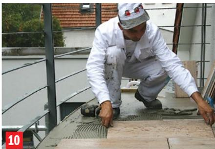
10 Nakon 24 sata naljepiti pločicu kombiniranom metodom lijepljenja „Buttering-Floating“, tj. ljepilo nanijeti na podlogu i poledinu pločice.
