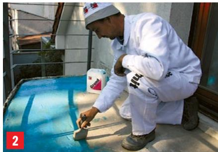
2 Podlogu očišćenu od prašine obrađujemo predpremazom Baumit Grund/SuperGrund.
