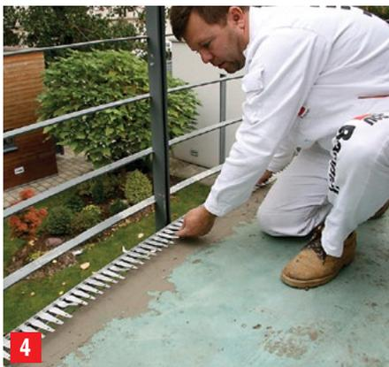
4 Na podložni plivajući sloj nanijeti predpremaz Baumit Grund. Baumit Balkonski profil postaviti duž balkonske konstrukcije tijekom realizacije 1. sloja hidroizolacijske mase Baumacol Protect 2K Elastic. Za brtvljenje spojeva pod/zid, odnosno dilatacijskih fuga na podlozi potrebno je upotrijebiti hidroizolacijsku traku Baumacol Traka za brtvljenje.
