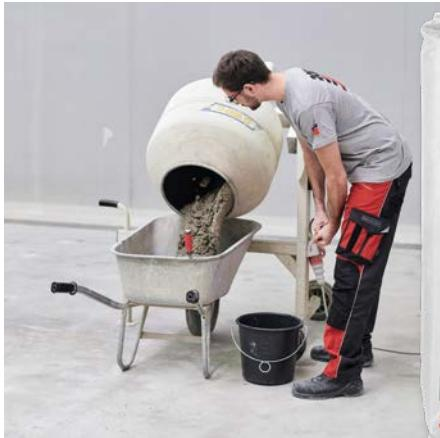
po vreći. Prilikom izrade same smjese postoje tri načina, korištenjem miješalice na slobodan pad, električnog ručnog mješača i ručnim miješanjem.
