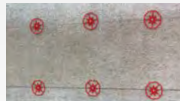
Baumit prva StarTrack pričvrsnica se postavlja na udaljenosti od 10 cm od ugla, mjereći vertikalno i horizontalno, pa potom svaka slijedeća na svakih 40 cm
