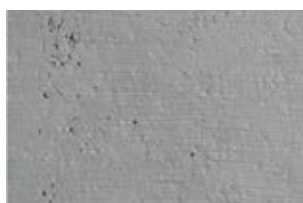
Tehnika grubog betona
