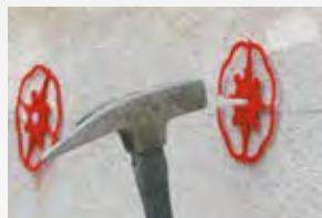
Baumit StarTrack se postavlja direktno na podlogu, te se na rozetu nanese ljepljivo
